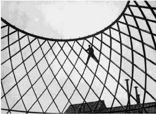
Otto Bartning Baustelle Deutscher Reichspavillon auf der Mailänder Messe, 1926 Fotograf unbekannt © Atlantik Photos & Co
